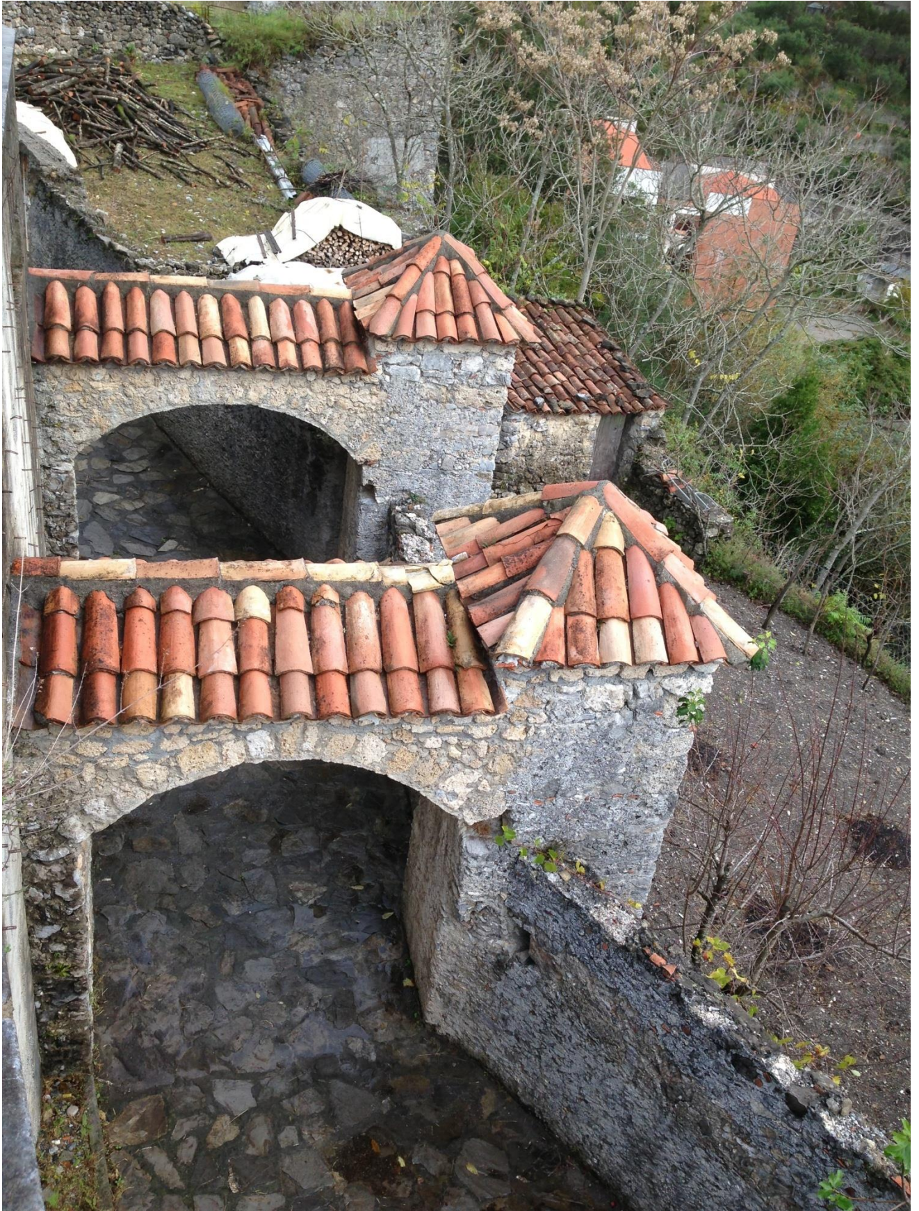
Fig. 16 – Papasidero: cinta muraria riadattata.
