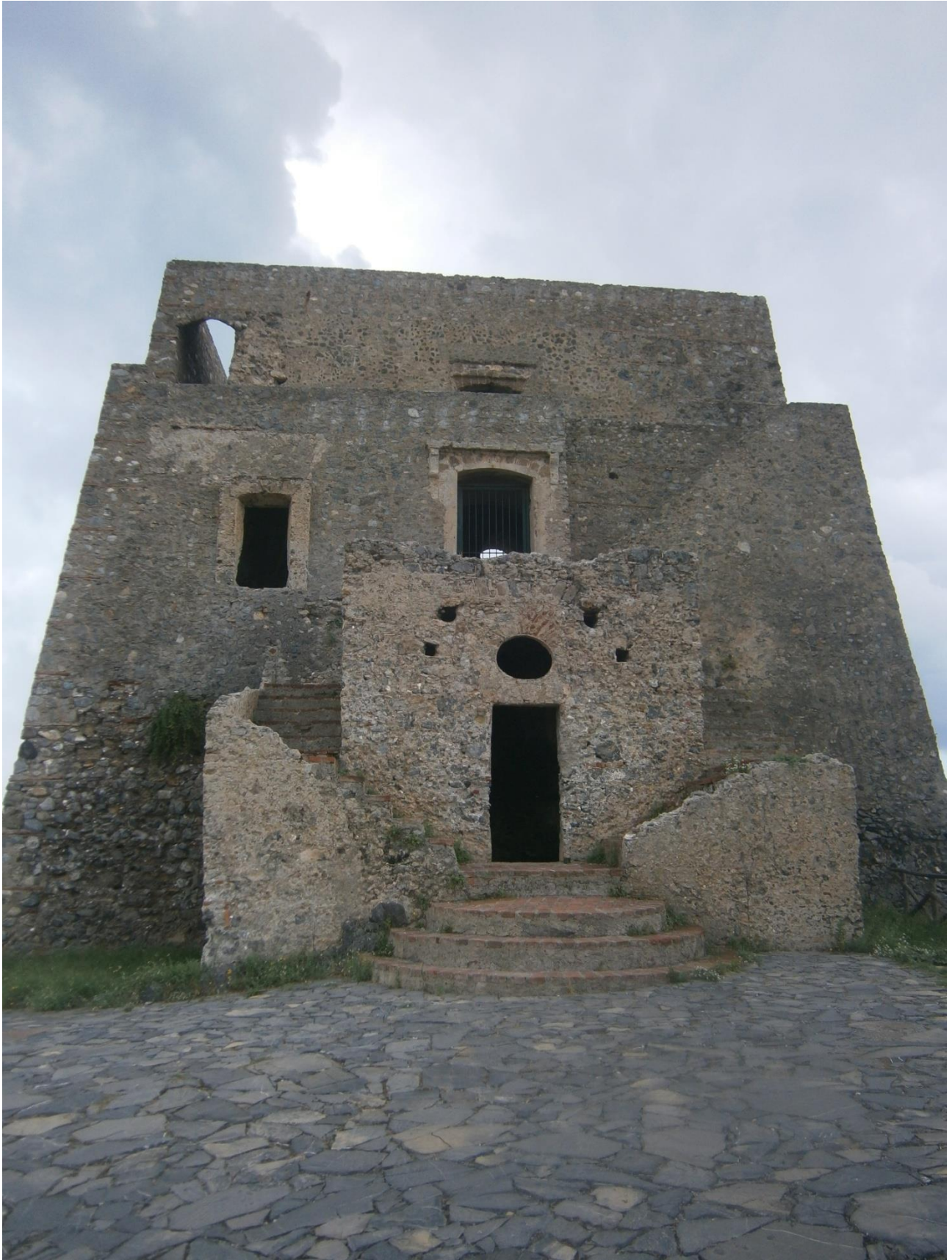
Fig. 22 – Torre Talao: facciata principale.
