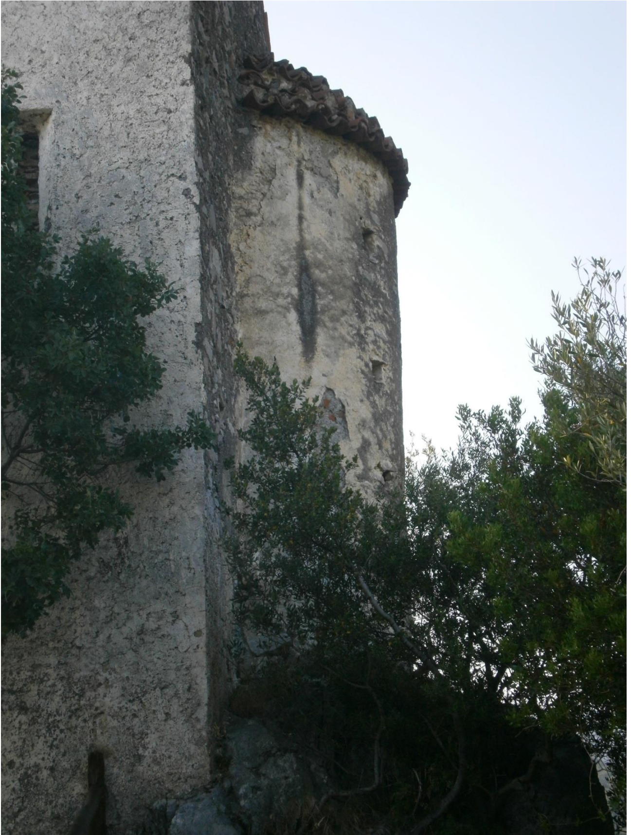
Fig. 18.1 – Chiesa di S. Maria di Mercuri: abside esterno.
