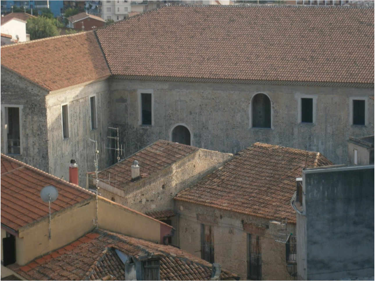
Fig. 17 – Palazzo Spinelli: vista del retro.
