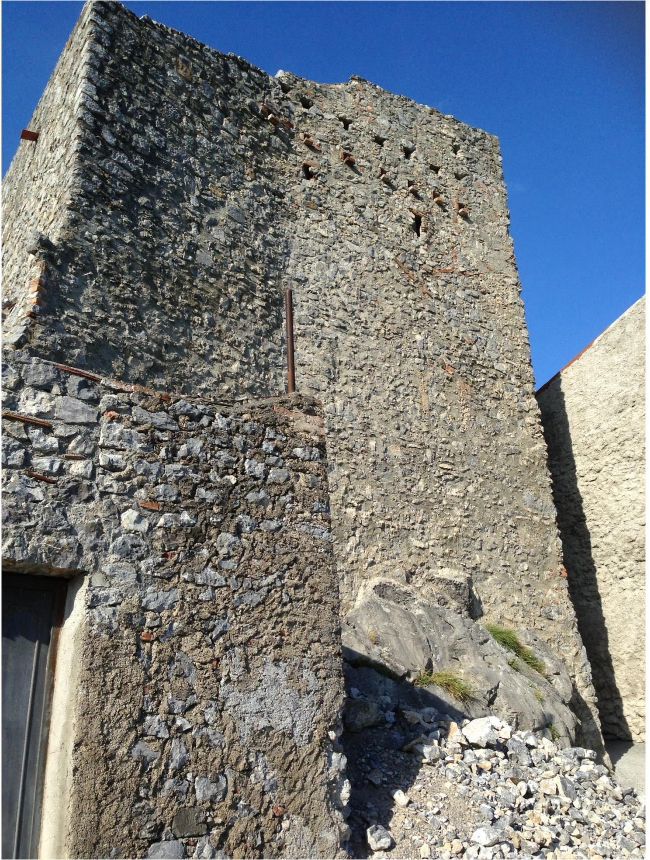
Fig. 13 – Palazzo Cosentini d'Aieta: torre esterna.
