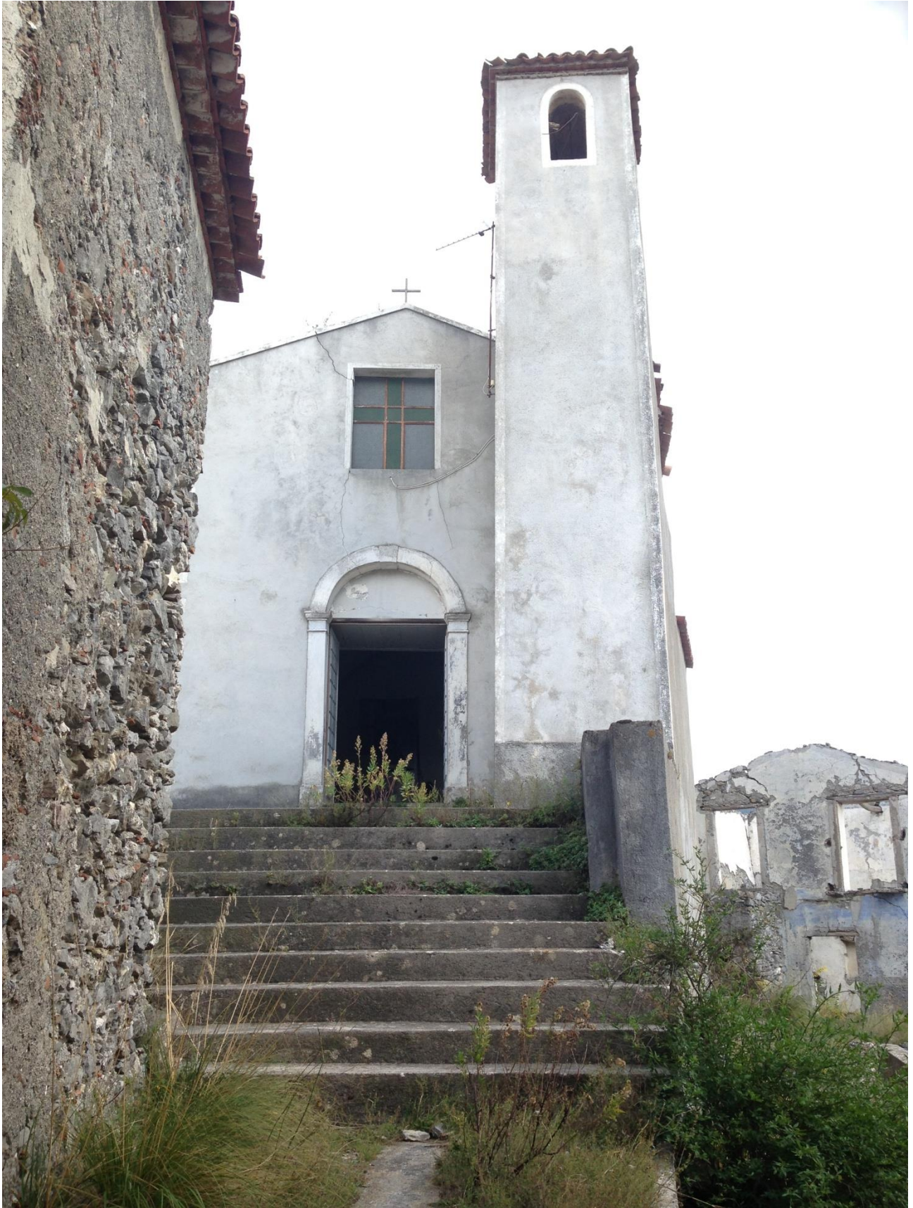
Fig. 19 – Chiesa della SS. Trinità di Avena: facciata (sec. XVIII).
