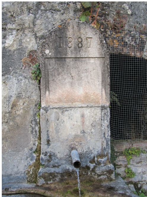
117. Carolei, Palazzo Quintieri. Data di realizzazione dei lavori al ninfeo
