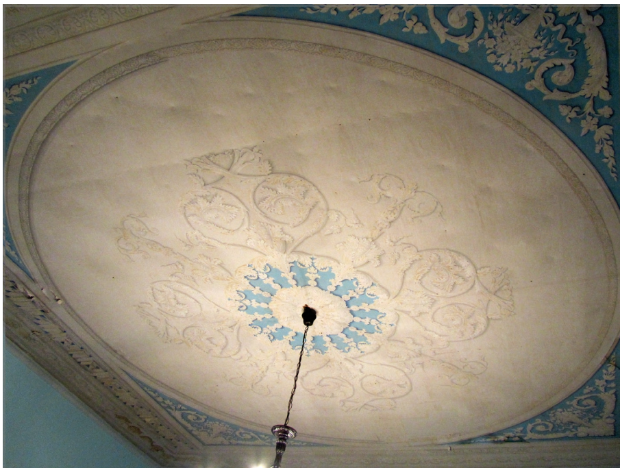
93. Rossano Calabro, Casino Amarelli. Soffitto del salottino
