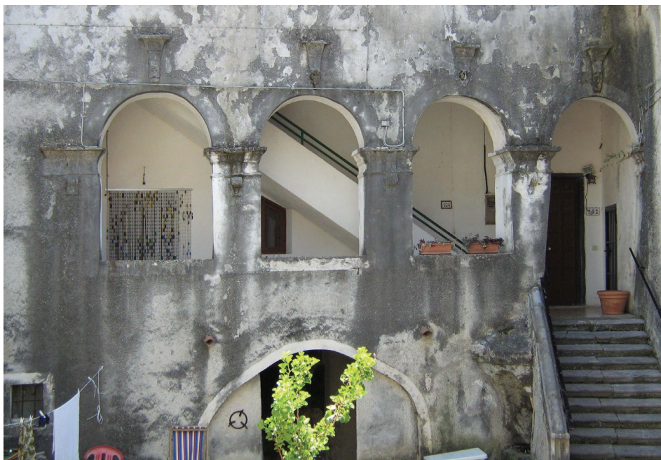
131. Tortora, Palazzo Lomonaco-Melazzi. Loggiato sulla corte interna
