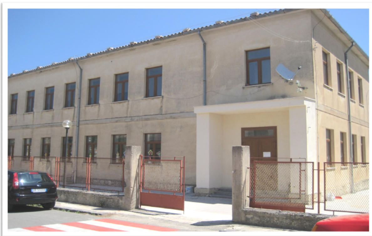
Foto n. 20: Plesso in frazione Pianello, I.C.S. di Petralia Soprana (PA) Fonte: FPC, 2011
