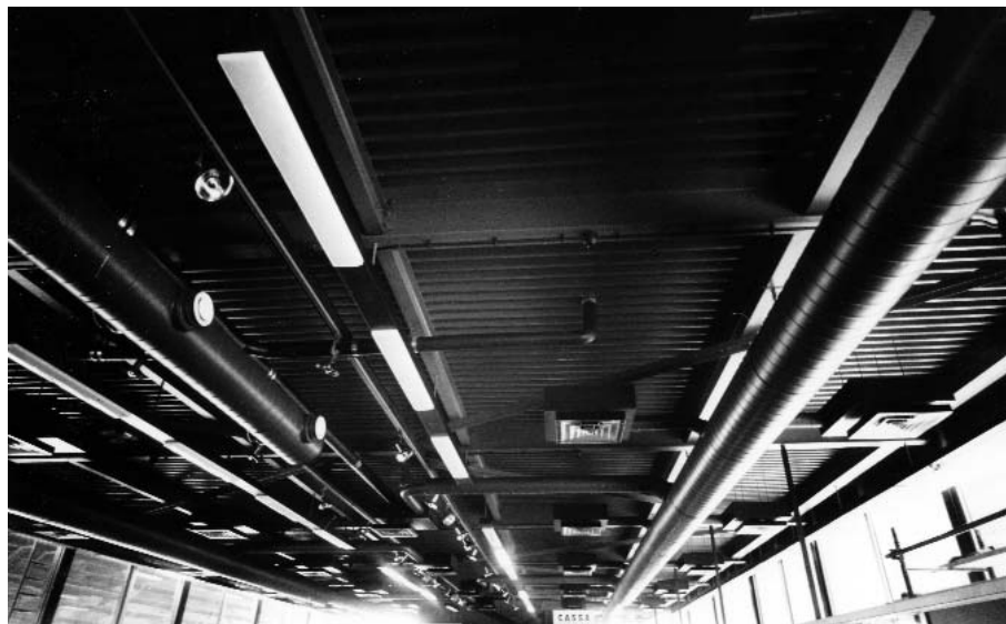
Fig.259 - L'intradosso del solaio dell'edificio ristoro. (AAB)
