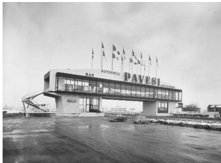
Fig.204 - Il piazzale dopo la rimozione dei piloni (AAB)
