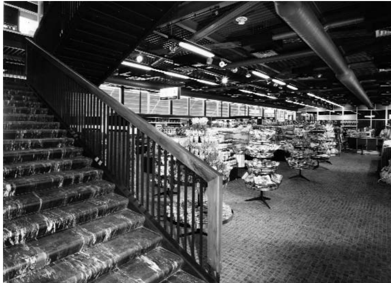
Fig.258 - Gli interni dell'autogrill. In evidenza la struttura e gli impianti lasciati a vista (AAB)
