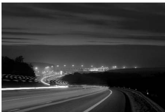
Fig. 310 - L'area di Hellebecq sull'autostrada A8 Bruxelles - Lille (Samyn & partners)
