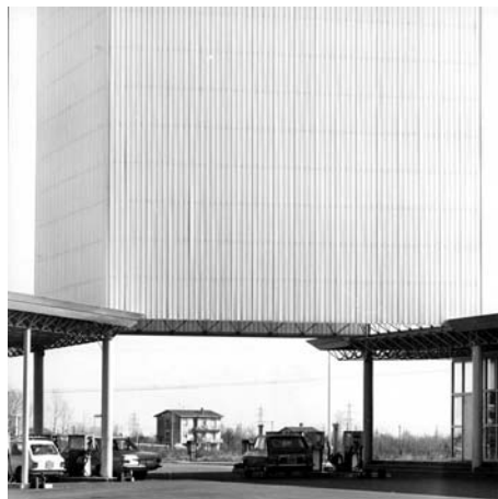
Fig.282 - Il cubo segna lo snodo tra l'edificio ristoro e l'area distributori - (Università IUAV- Archivio Progetti, Fondo Costantino Dardi ©)
