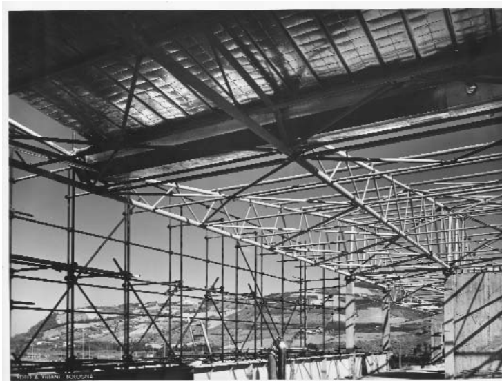
Fig. 219 - 220 - La struttura metallica della copertura del ristorante (AMB)
