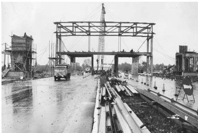
Fig.198 - Il tronco centrale della struttura del ponte (AAB)
