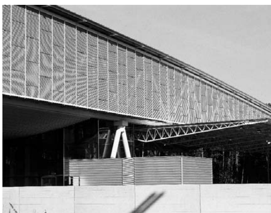
Fig. 308 - Lo schermo in lamiera stirata sulla facciata dell'edificio ristoro (Samyn & partners)
