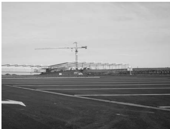
Fig. 318-320 - Il cantiere dell'area di Hellebecq - (Samyn & partners)
