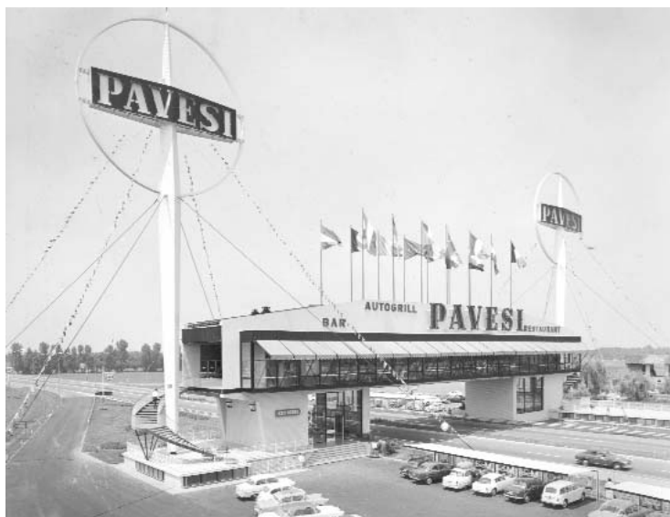
Fig. 189 - Il piazzale di Fiorenzuola. In evidenza i piloni pubblicitari (AAB)
