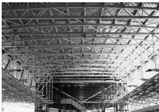
Fig. 306- L'intradosso del solaio di calpestio del piano ponte. (Samyn & partners)
