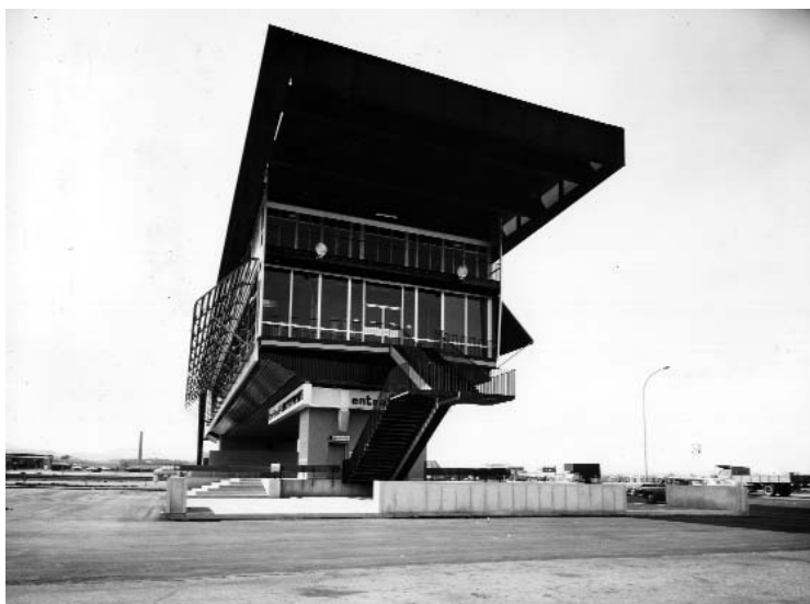
Fig.246 - Una delle testate con la scala esterna (AAB)
