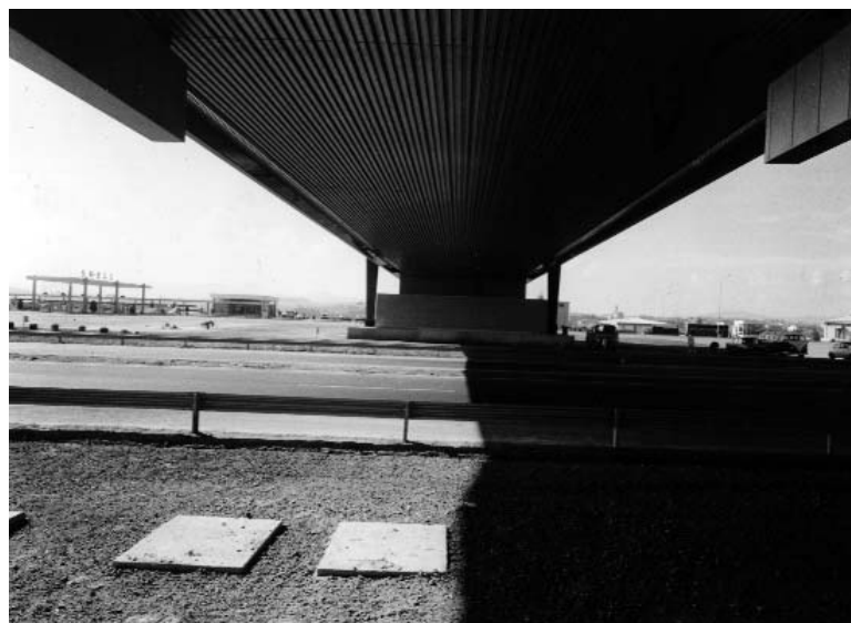
Fig.257 - L'intradosso del solaio di calpestio del primo piano ponte, lasciato a vista sull'autostrada.(AAB)
