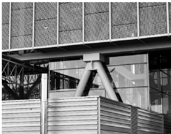
Fig. 307 - Uno degli appoggi delle travi Warren (Samyn & partners)
