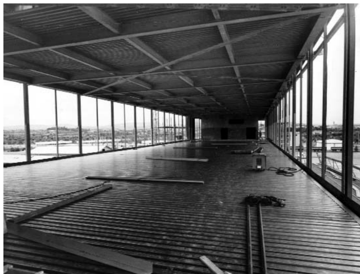
Fig.255 Uno dei solai dell'edificio nella fase di montaggio (AAB)
