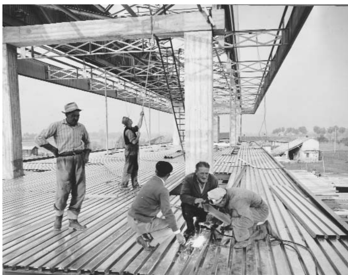
Fig.199 - Il montaggio del solaio di calpestio del piano ponte (AAB)
