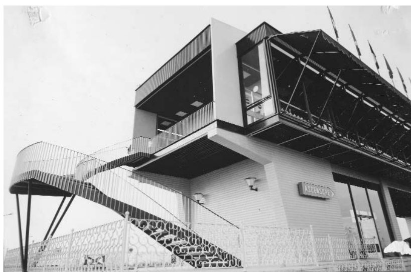
Fig. 200 - La facciata è schermata da un frangisole metallico a lamelle orizzontali (AAB)
