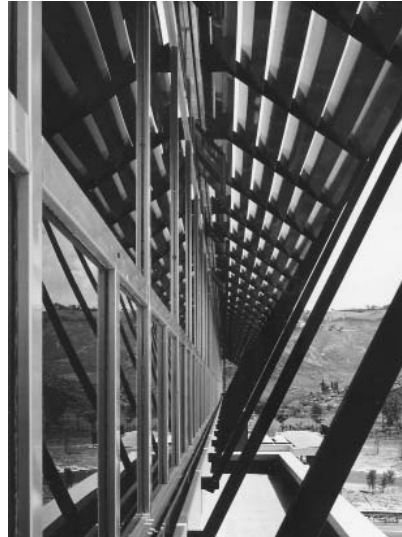
Fig.221 Il frangisole a lamelle orizzontali (AMB)
