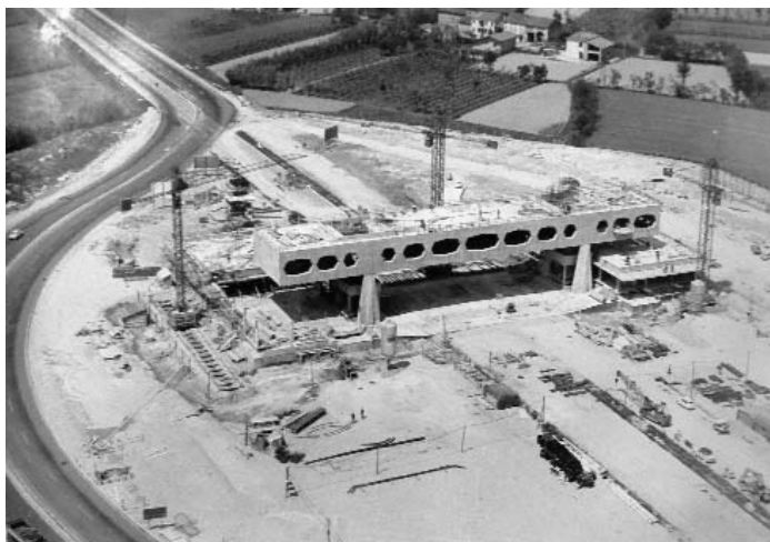
Fig.277 - Il cantiere. (Archivio Nervi, Roma, DARC, MAXXI Architettura)
