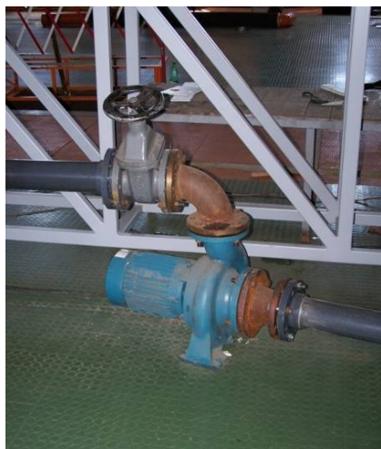
Figura 37 – Corpo pompa - saracinesca
