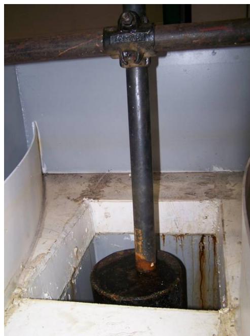
Figura 33 – Collegamento fondo in PVC - pozzetto cassone
