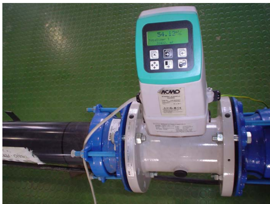
Figura 41 – Misuratore elettromagnetico di portata
