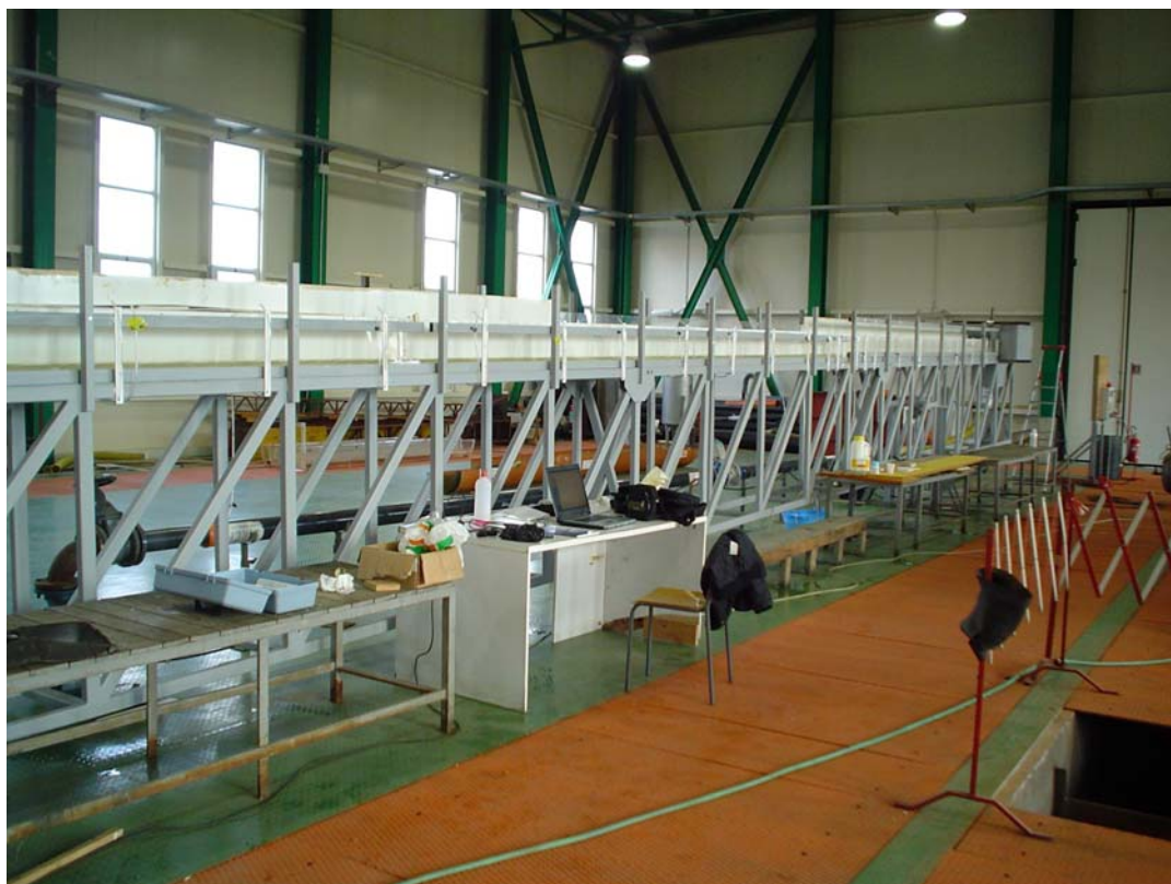
Figura 42 – Piezometri installati lungo la canaletta
