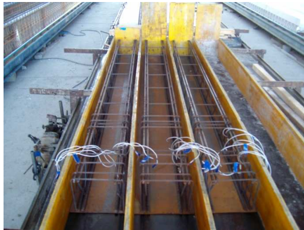
Figura 4.12: Fase di getto Travi B
