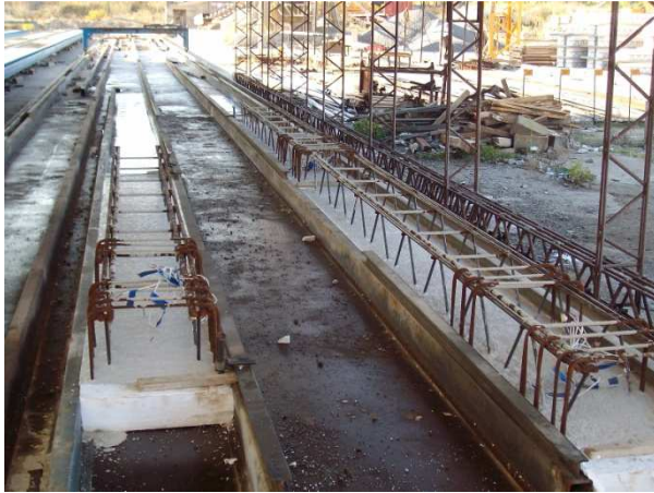
Figura 4.11: Getto del fondello Travi C
