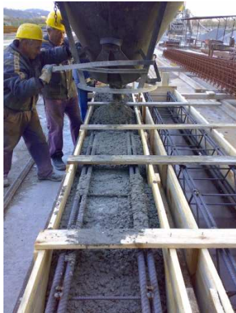
Figura 2.2: Getto delle travi PREM e prelievo dei cilindri
