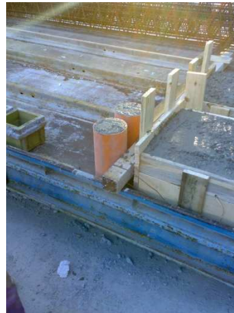
Figura 2.2: Getto delle travi PREM e prelievo dei cilindri
