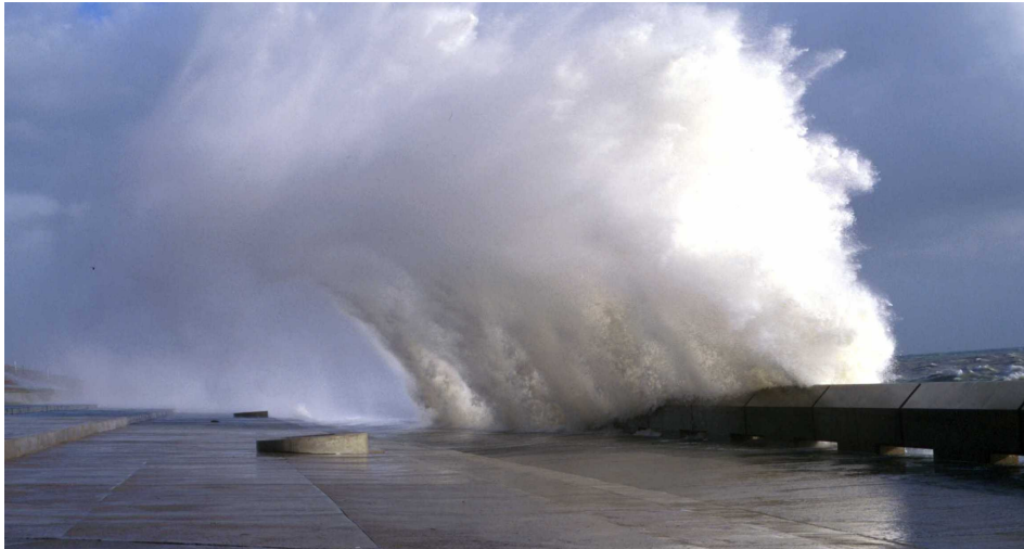
Figura 2.1: Il fenomeno di tracimazione dell'onda sul Samphire Hoe seawall, UK, (da CLASH project, www.clash-eu.org (2001))
