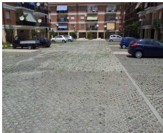
Scenario 1: pavimentazione carrabile con betonelle prefabbricate grigliate per l'interposizione del manto erboso
