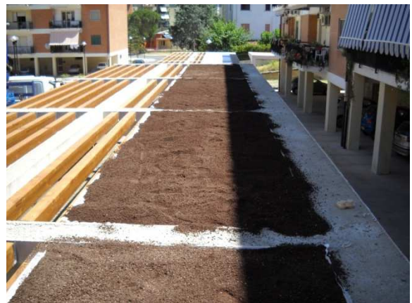
Fasi di lavorazione del tetto verde
