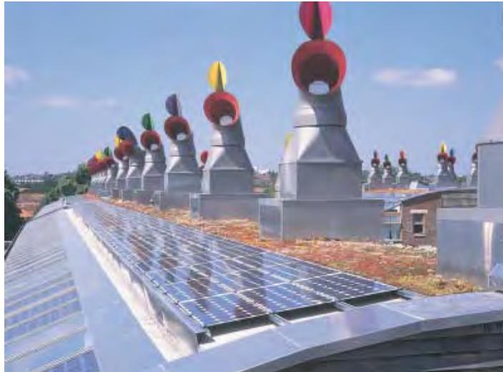
Fig. 2.15: Mix di energia rinnovabile: fotovoltaico e camini a vento. (Fonte: © Arup/Raf Makda/VIEW)
