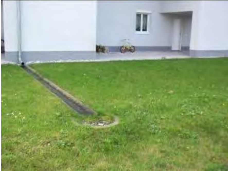
Fig. 2.6: Sistema di recupero dell'acqua piovana.
