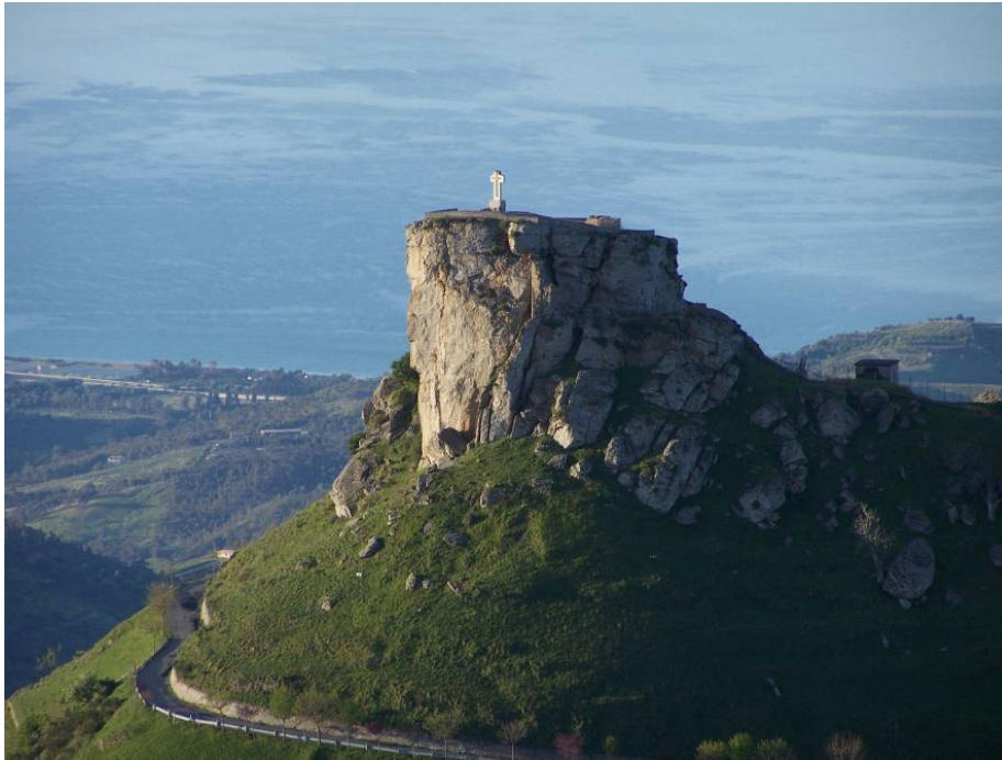
Fig. 15. Il Castello di Bova visto da Nord-Est.
