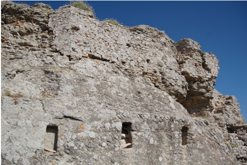
Fig. 11. Immagine dei fori scavati nella roccia per il probabile solaio ligneo.
