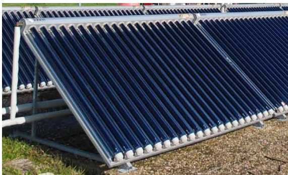
Figura 2.11 - Collettori solari a tubi evacuati sottovuoti e circuitazione del fluido termovettore.
