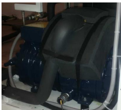
Figura 6.70 – Coibentazione del compressore.
