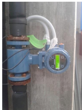
Figura 6.10 - Misuratori di portata dell'acqua, Krohne optiflux 5000 e Rosemount 8732E.
