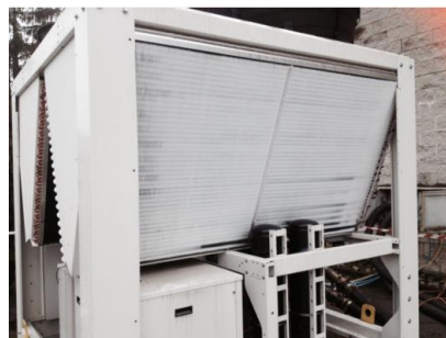
Figura 3.9 – Variazione percentuale del COP rispetto al COP nominale di una pompa di calore con sorgente aria [6] e formazione di brina all'evaporatore.
