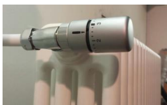
Figura 7.19 - Valvole e testa termostatiche tradizionali del tipo on/off.
