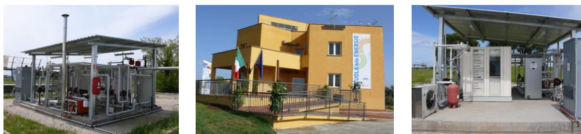
Figura 5.2 - Centrale di produzione e edificio F-92.
