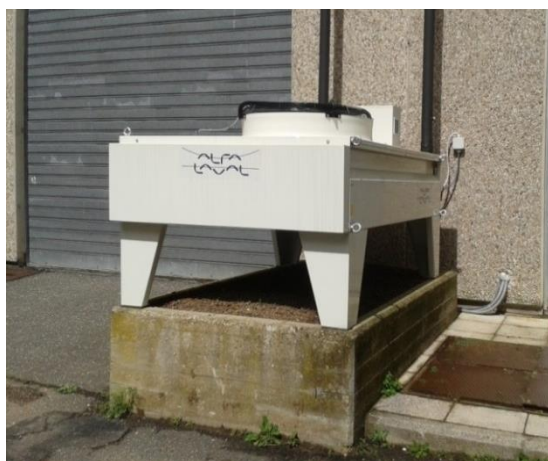
Figura 4.7 - Dry - cooler facente parte del circuito idronico.
