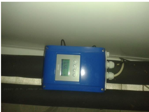
Figura 6.10 - Misuratori di portata dell'acqua, Krohne optiflux 5000 e Rosemount 8732E.
