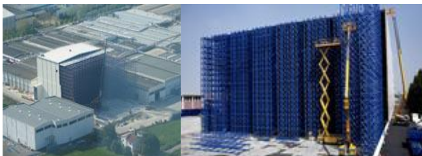
Figura 2.3 Edificio sorretto interamente da scaffalature senza supporti in muratura.
